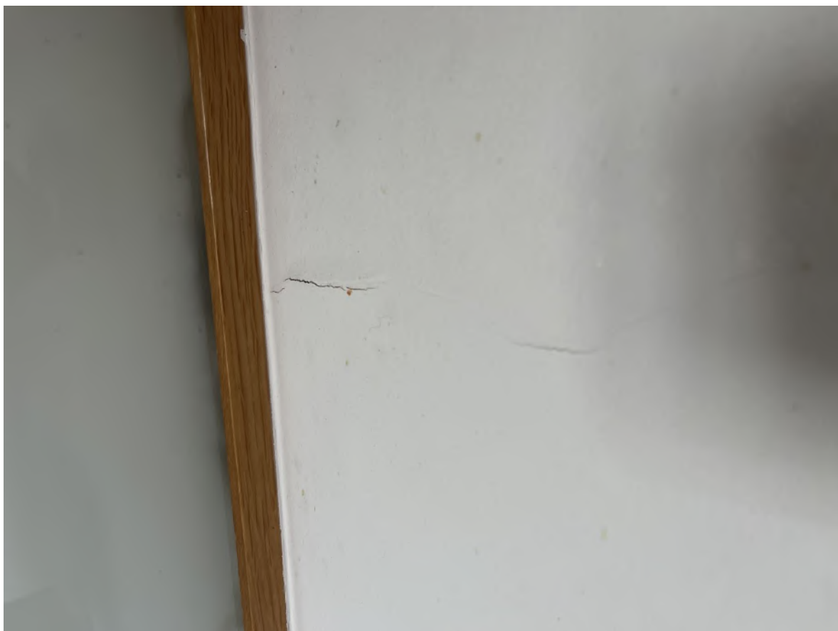
Zdjęcie. Ściany/sufit położony w Salon z aneksem kuchennym
